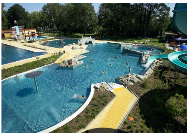
Zones pour les nageurs, les plongeurs et les attractions avec le toboggan aquatique Surface d'eau : 1.625 m 2 | Année de construction 2004
