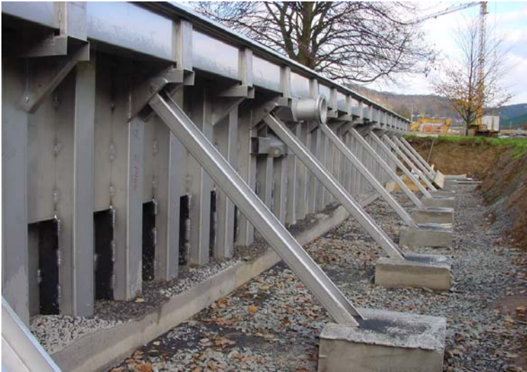
Les supports arrière supportent les parois en acier inoxydable
