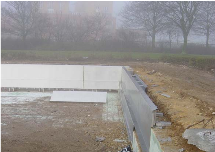
Die Edelstahlelemente werden direkt auf die abgetragene Wand montiert
