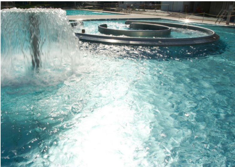
Saniertes Erlebnisbecken mit Strömungskanal, Wasserpilz und Rutsche Wasserfläche: 945 m 2 | Baujahr 2002
