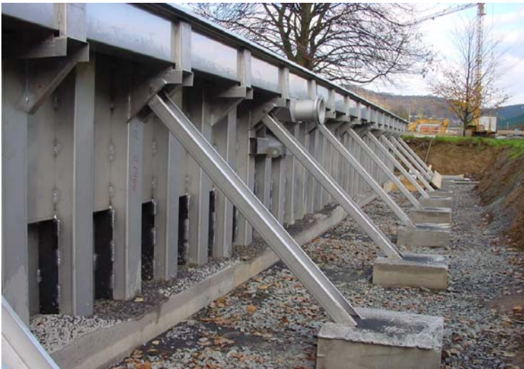
Die hinteren Träger stützen die Edelstahlwände ab
